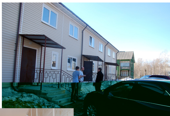
В доме по адресу: ул. Ударников, дом 21 выкуплены 7 квартир для переселения жителей из аварийного жилья
